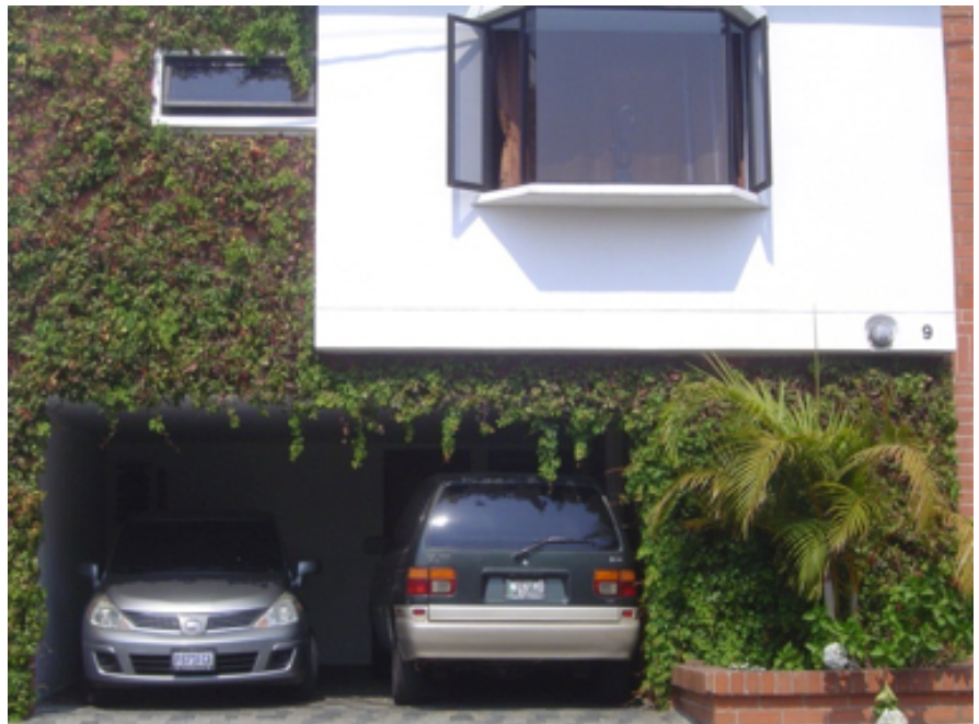
Figura 10. Godínez R. Planta cubriendo partes deseadas de la fachada de una vivienda, dejando como resaltado el plano de la ventana en color blanco para contrastar con el verde de la planta. Mayo 2014. Casa No. 9 del Condominio "Jardines de Zaragoza" 17 avenida, zona 4 de Mixco
