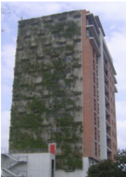
Figura 9. Godínez R. Fachada manchada a consecuencia de poca uniformidad en el crecimiento de la planta cubridora, debido al diseño y ubicación de jardineras y complicación en el riego y mantenimiento transmite poco éxito de la propuesta. Mayo 2014. Edificio de Oficinas "El Naranjo" Condado Naranjo zona 4 de Mixco, Guatemala.
