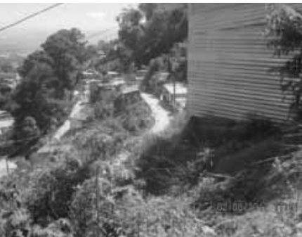
Figura 11. Vivienda informal construida en ladera propensa a deslizamiento.
