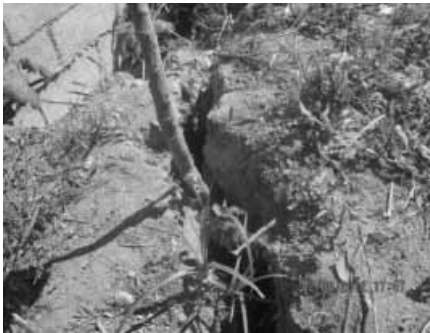
Figura 10. Grieta con una profundidad de más de 6 metros. Ubicada en la Asunción..
