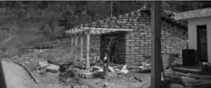
Figura 14 Nueva construcción de adobe a la par de una de concreto
