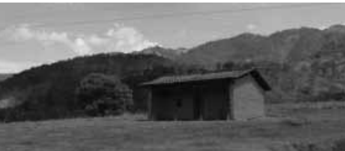
Figura 15 Casa típica en teja, columnas de madera y adobe.
