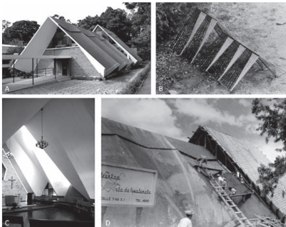
Figura 1: A) Foto vista exterior de Iglesia Champagnac. Foto: John Turton, 2012. B) Maqueta de estudio para la cubierta de la iglesia. Foto: reproducción del archivo fotográfico de la familia Castillo. C) Foto vista interior de la Iglesia. Foto: John Turton, 2012. D) Proceso constructivo de la cubierta. Foto: reproducción del archivo fotográfico de la familia Castillo.
