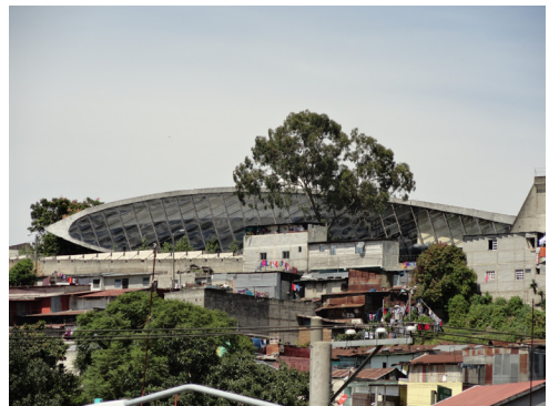
Figura 23. Vista lejana del gimnasio del Colegio Don Bosco desde el centro moderno de la ciudad, imagen tomada por el autor agosto 2018.
