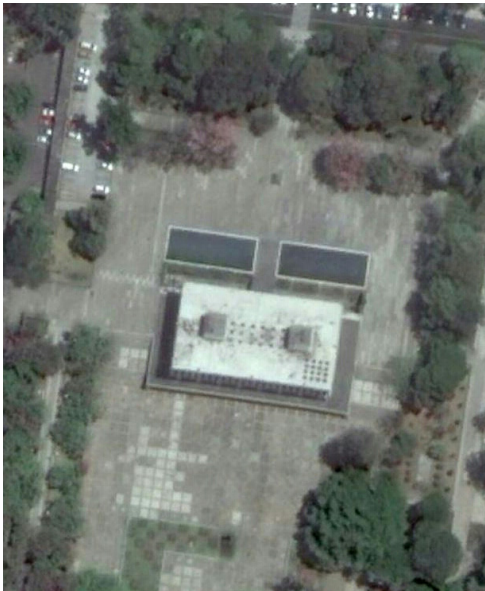
Figura 4. Vista aérea de las plazas y edificio de la rectoría de la Ciudad universitaria. Imagen tomada de Google Earth abril 2016.
