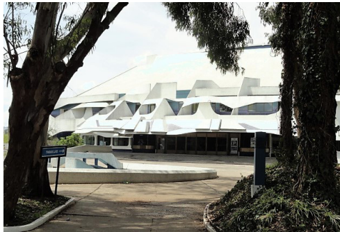
Figura 28. Vista de la fachada de acceso del Gran Teatro del Centro cultural de Guatemala. Fotografía del autor, mayo 2018.
