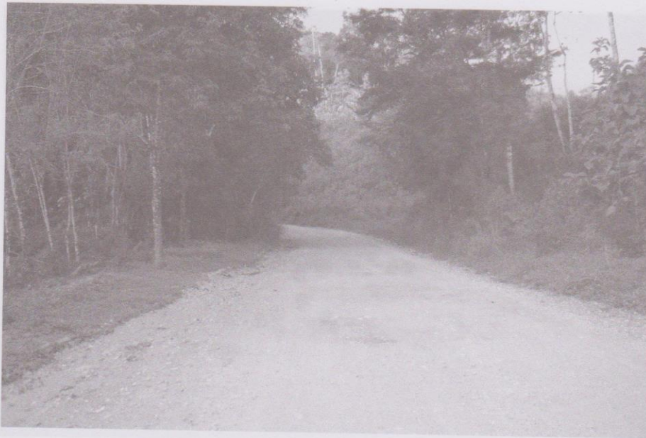
Franja Transversal del Norte sin pavimentar, acceso a la aldea Quebrada Seca.
