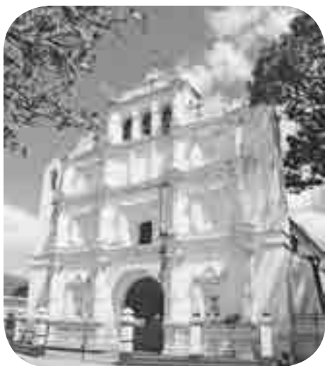
Parroquia San Mateo Apóstol, el principal recinto católico en Salamá.
