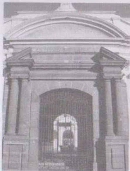
Portada MUSAC, obra de Diego de Porres.
