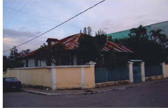
Figura 20. Una de las casas llamadas “americanas” que se encuentran en el antiguo barrio San Antonio. Fotografía: Chajón, junio 2012.
