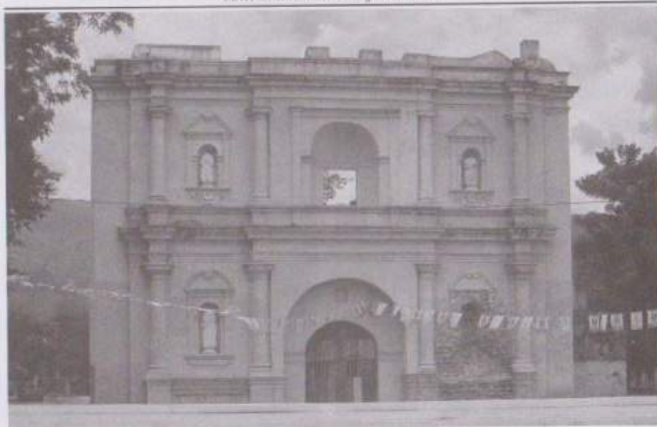
Fachada restaurada, Iglesia Vieja.
