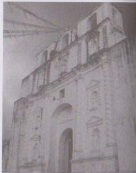
Fachada, elementos manieristas.
