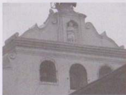
Parte posterior de la espadaña.
