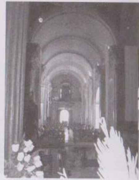
Nave central, ventanas semiocultas barrocas.
