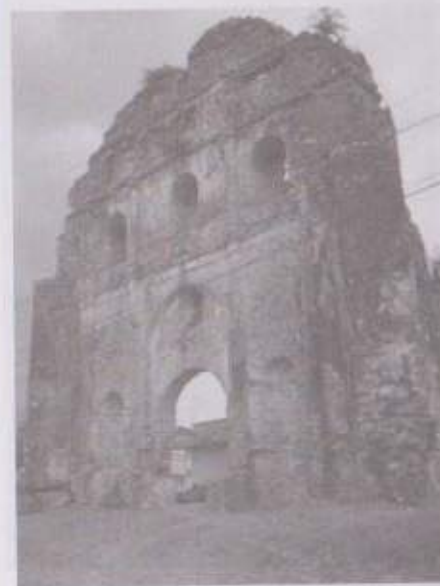
Fachada, elementos manieristas.
