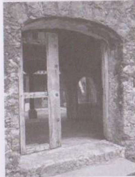
Portón de acceso original.
