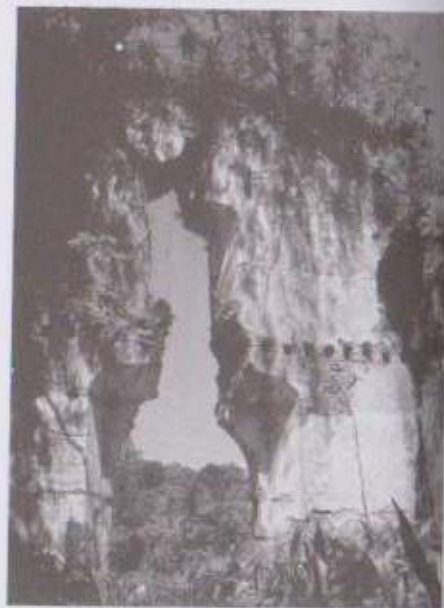
Ventana coral y puerta en ruinas, Santa Inés.
