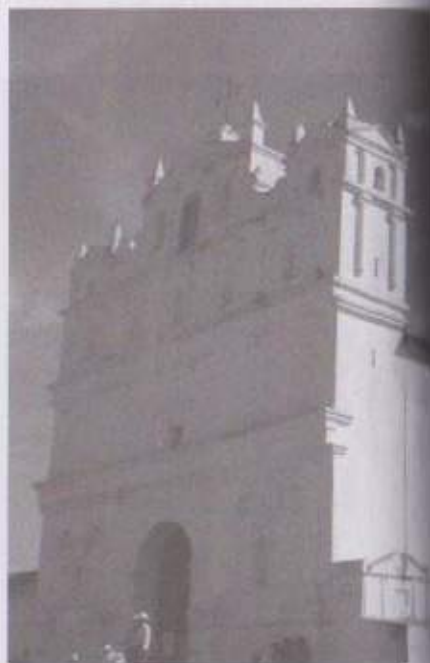
Fachada, elementos manieristas.
