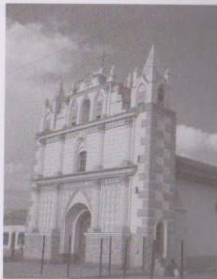
Fachada, ecléctica por elementos neoclásicos y neogóticos.
