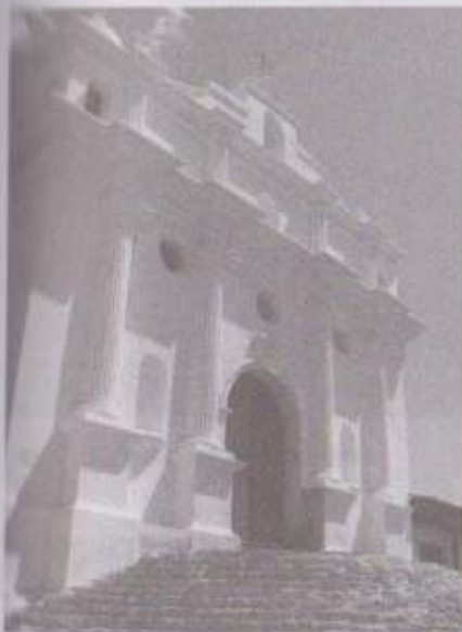
Fachada, elementos manieristas.
