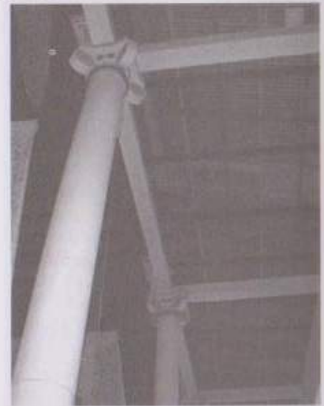
Columnas de madera.
