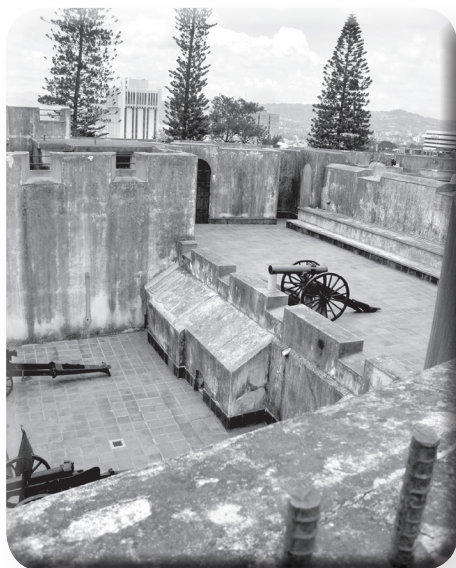
Azotea del fuerte de San José Buena Vista.
