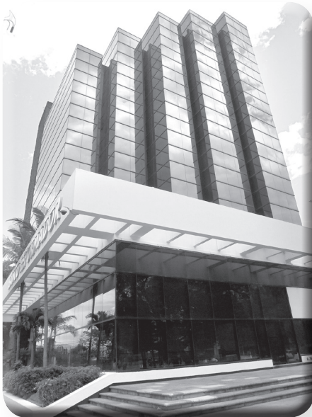
Edificio Banco SCI, ahora Reformador.
