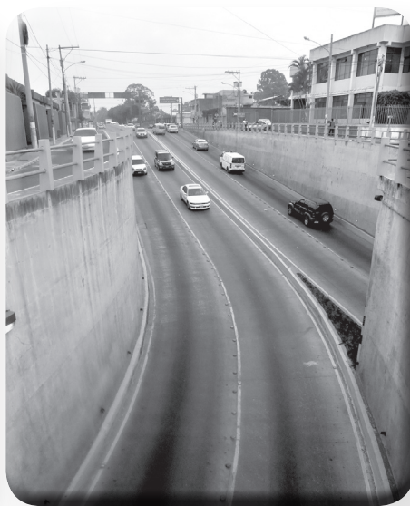
Viaducto de la 13 calle y Calzada Aguilar Batres.
