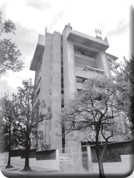
Torre de la Empresa Guatemalteca de Telecomunicaciones, ahora Claro.
