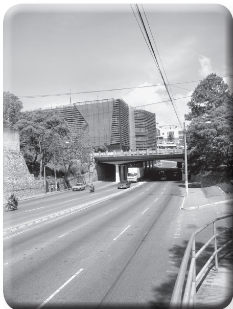
Viaducto, 7ª Avenida y 24 calle zona 4.
