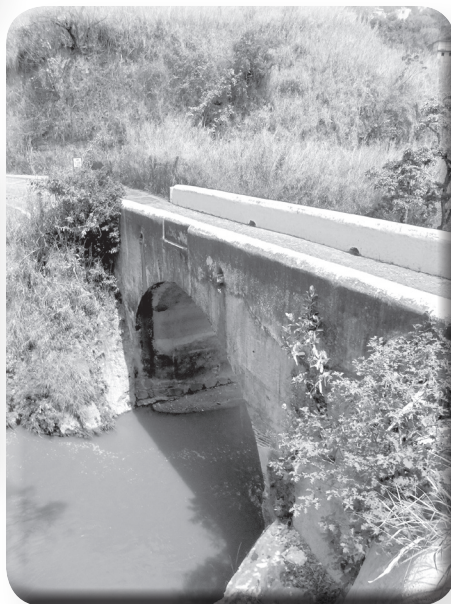
Puente del Castaño.
