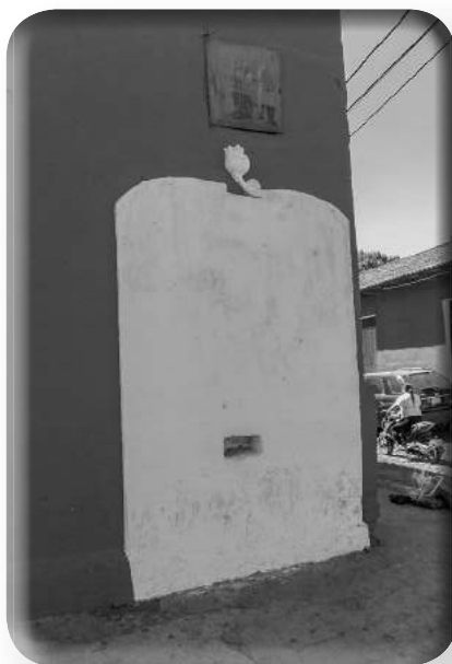
Caja de distribución de agua.
