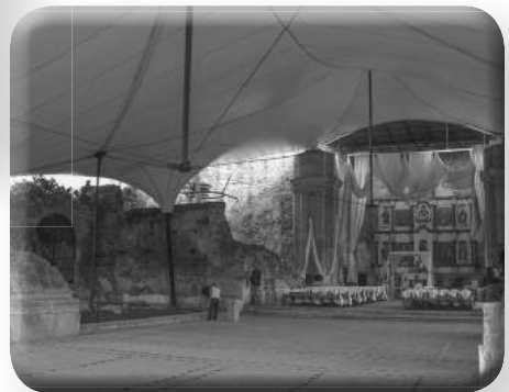
Nave central del templo, con cubierta actual.
