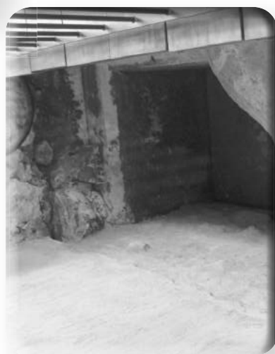
Restos de pretil del siglo XVII, bajo la construcción del siglo XVIII conocida como de Sor Juana.
