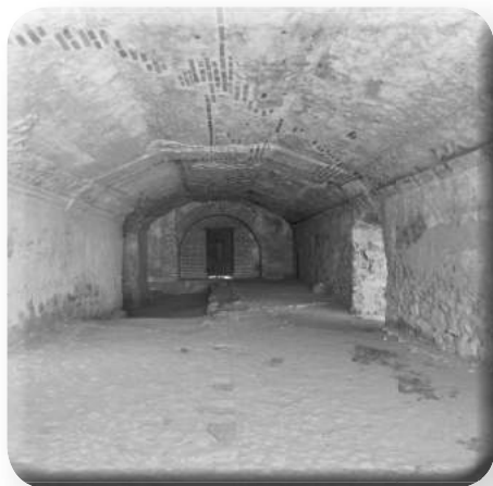
Refectorio, con cubierta decorada con ataurique.
