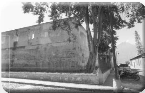
Convento de Santa Teresa, se perdió el muro exterior, alineado con el resto de inmuebles.
