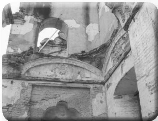
Restos del claustro.
