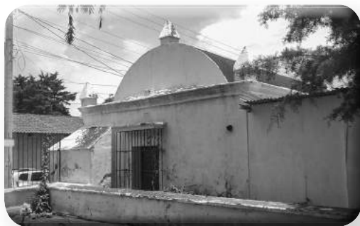
Exterior de la capilla.
