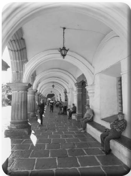
Pórtico, primer piso.
