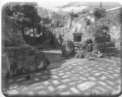
Restos de la fachada del templo de Nues- tra Señora de los Dolores del Llano.
