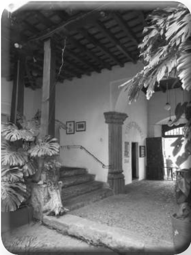
Acceso del patio al corredor y zaguán del colegio.
