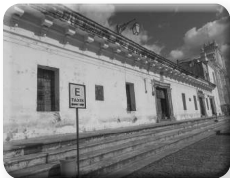
Fachada del Palacio Episcopal.
