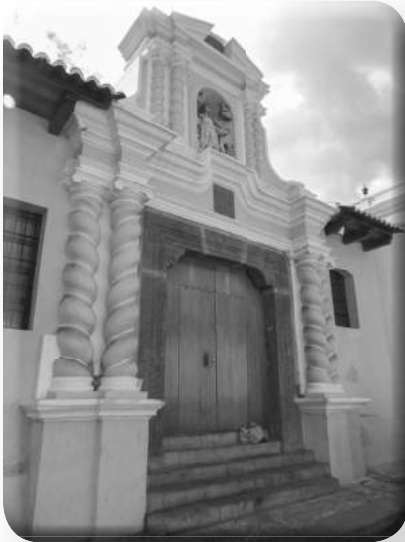
Ingreso al Hospital de San Pedro.
