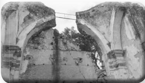
Muro testero del templo.
