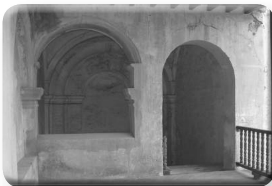
Acceso a la escalera principal, segundo piso.
