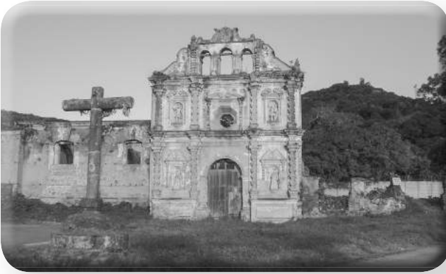
Fachada del templo del pueblo de Santa Isabel.
