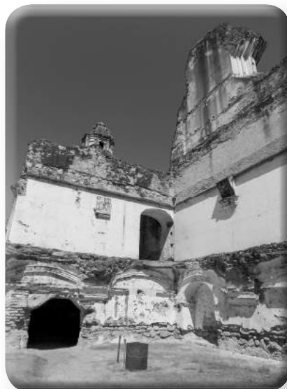
Restos de las pandas del claustro, en el acceso a una escalera, con linternilla.
