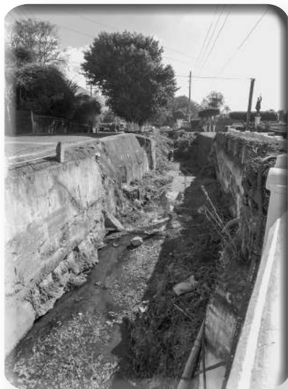
Río Pensativo, bajo el puente Matasano.
