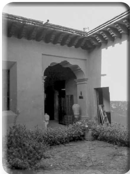
Patio de la cocina.
