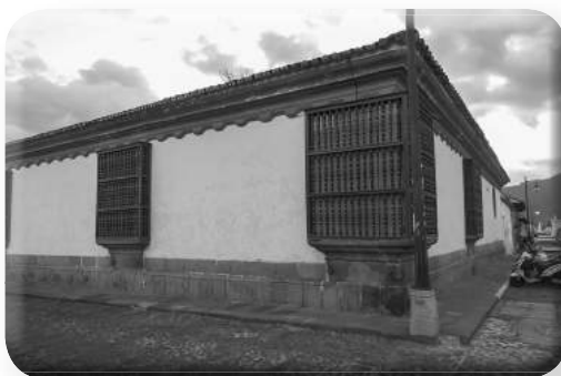
Ventana de esquina de la casa.
