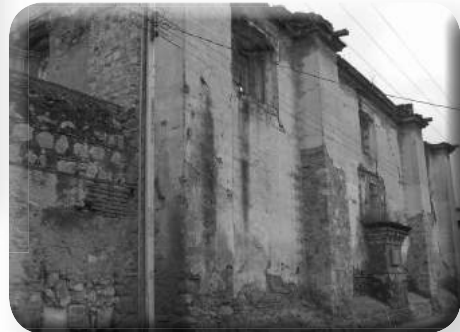
Exterior del muro testero.
