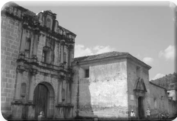
Fachada del templo y convento de Nuestra Señora del Pilar de Zaragoza, conocido como Capuchinas.
