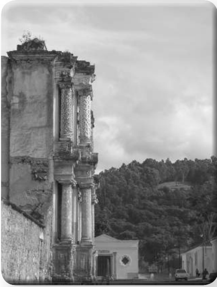
Vista de la fachada lateral.
