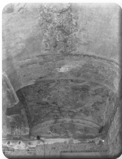
Bóveda rebajada en el convento.
