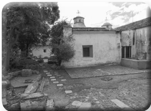
Patio interior del colegio.
