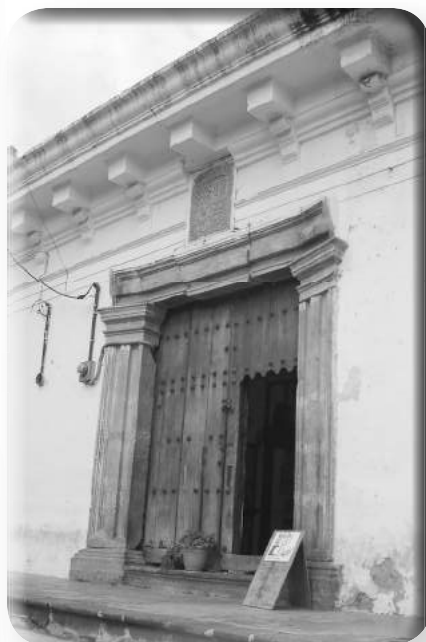
Ingreso al Palacio Episcopal.
