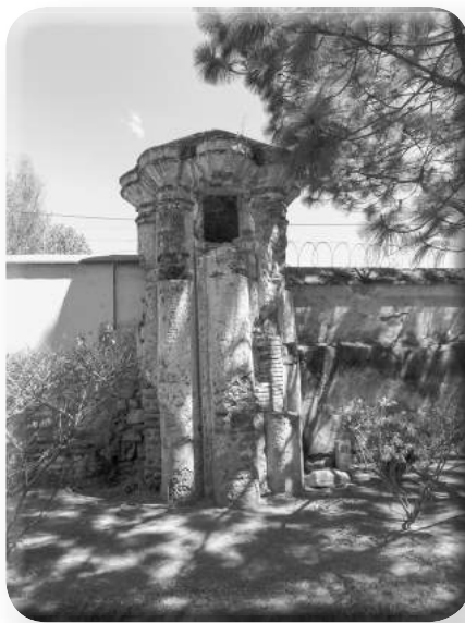
Caja barroca de distribución de agua, con movimiento de masa mural
