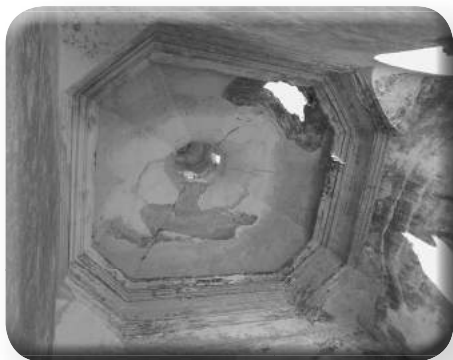
Cubierta de la escalera, con la linternilla.
