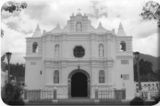
Fachada del templo de San Lázaro.
