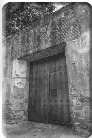
Ingreso del Hospital.
