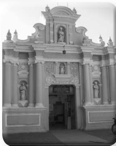
Fachada de ingreso al Hospital.
