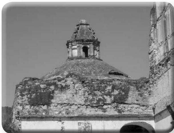
Linternilla sobre las escaleras.
