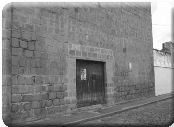
Ingreso principal de la Casa de Moneda.
