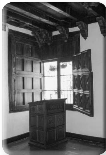
Ventana de esquina desde el interior.
