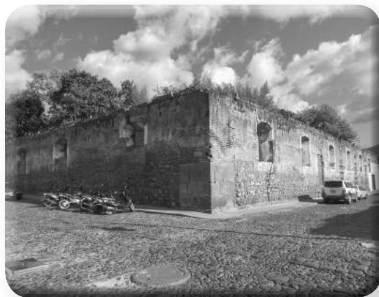
Muro exterior de los restos del Hospital Real de Santiago, conocido como de San Juan de Dios.
