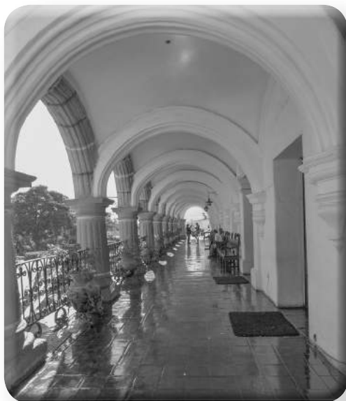
Pórtico, segundo piso.
