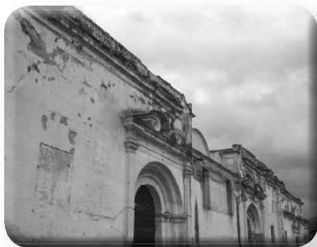
Muro testero de la Catedral.
